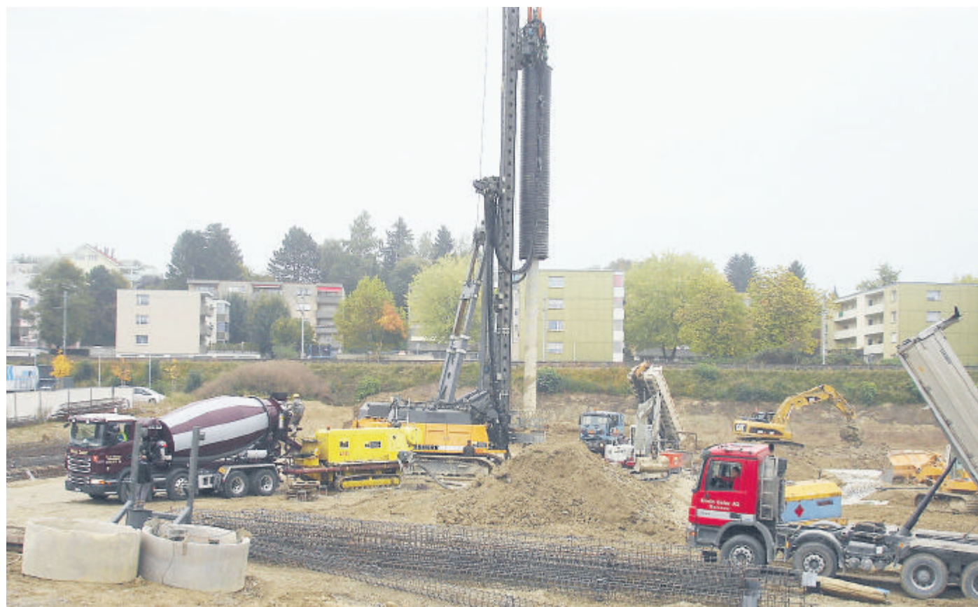
1000 PS im Einsatz: Auf dem Gelände der Fitness-Island in Bronschhofen werden Pfähle in den Boden gerammt.
